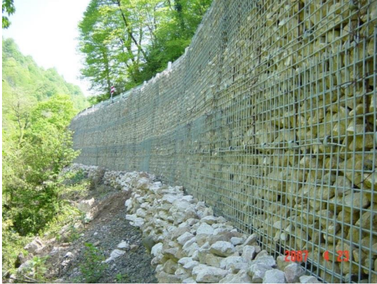
شکل ۲۸- نمای مش فولادی در دیوار خاک مسلح
