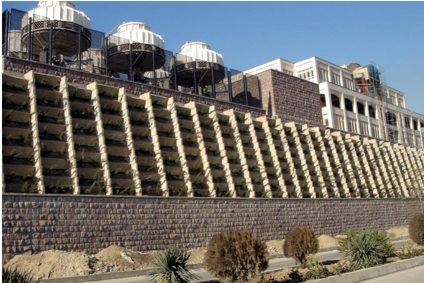
شکل ۶- نمای دیوار خاک مسلح- گلدانی و خاک مسلح با نمای سنگی
