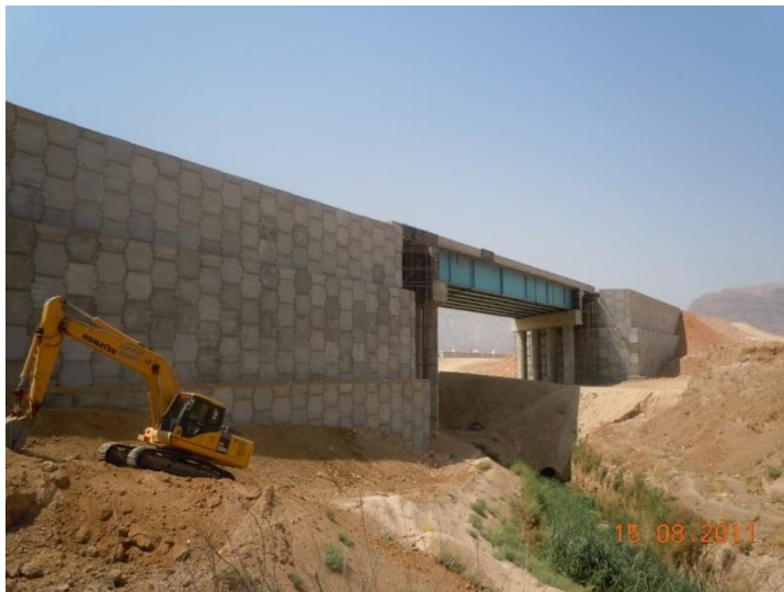
شکل ۳- دیوار خاک مسلح- پایه کناری پل‌ها
