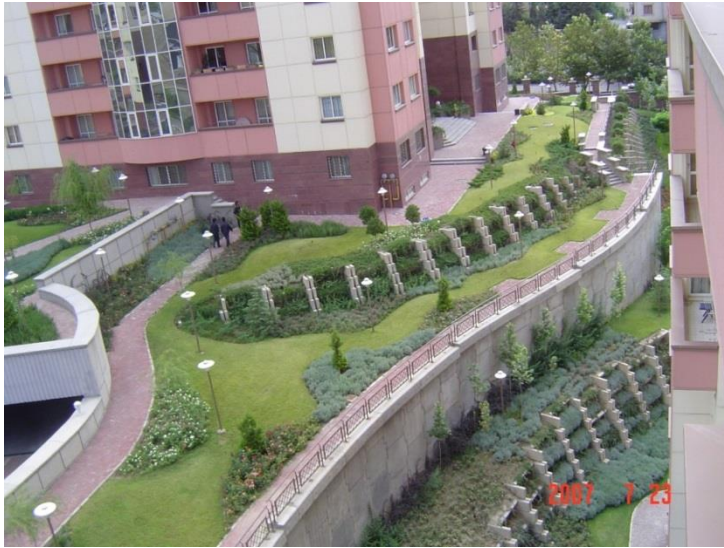
شکل ۲- دیوار خاک مسلح اطراف ساختمان مسکونی
