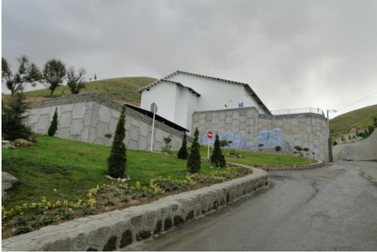
شکل ۴- زیرسازی ساختمان صنعتی
